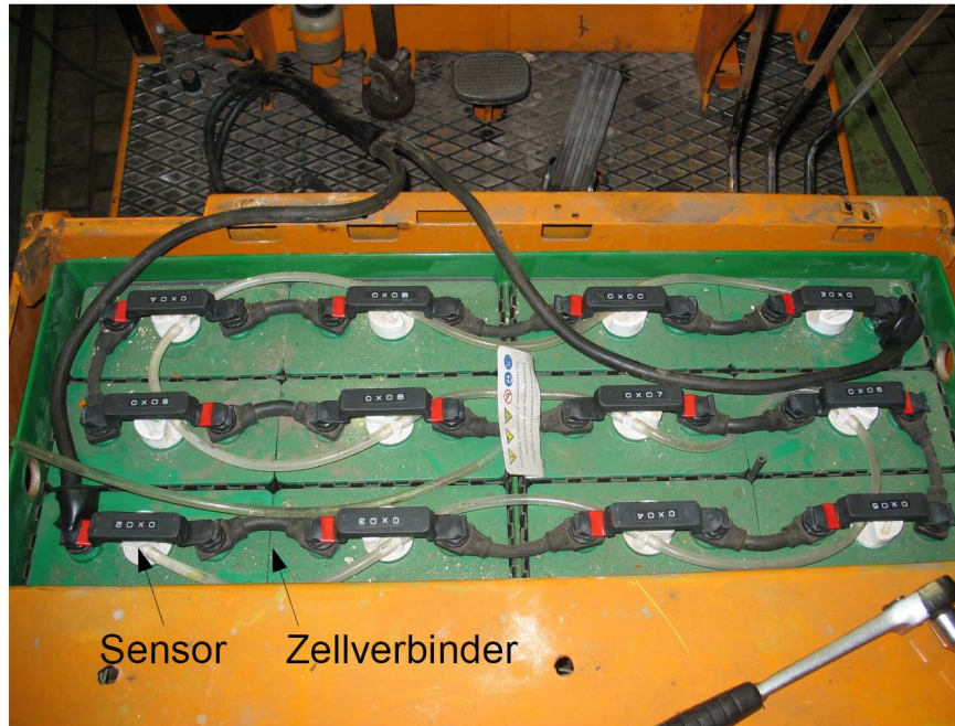
Sensoren auf dem Gabelstapler der HAW
